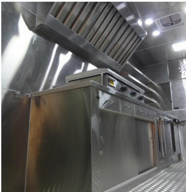
**Tecnologia Avançada:** A tecnologia utilizada no filtro realiza a captação de micropartículas e a esterilização do ar, eliminando eficazmente vírus, bactérias e gordura.
